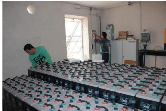
La instalación cuenta con una instalación fotovoltaica de 47 KWp y dos inversores de red de 20 Kw cada uno. La acumulación de electricidad se realiza en un banco de baterías formado por 72 vasos de 2V, con una capacidad de acumulación de 4.590 Ah. La instalación cuenta también con un grupo electrógeno de seguridad de 120 KVA, que entra en funcionamiento sólo si se producen picos de consumo o si las baterías se descargan por debajo de un determinado nivel.
